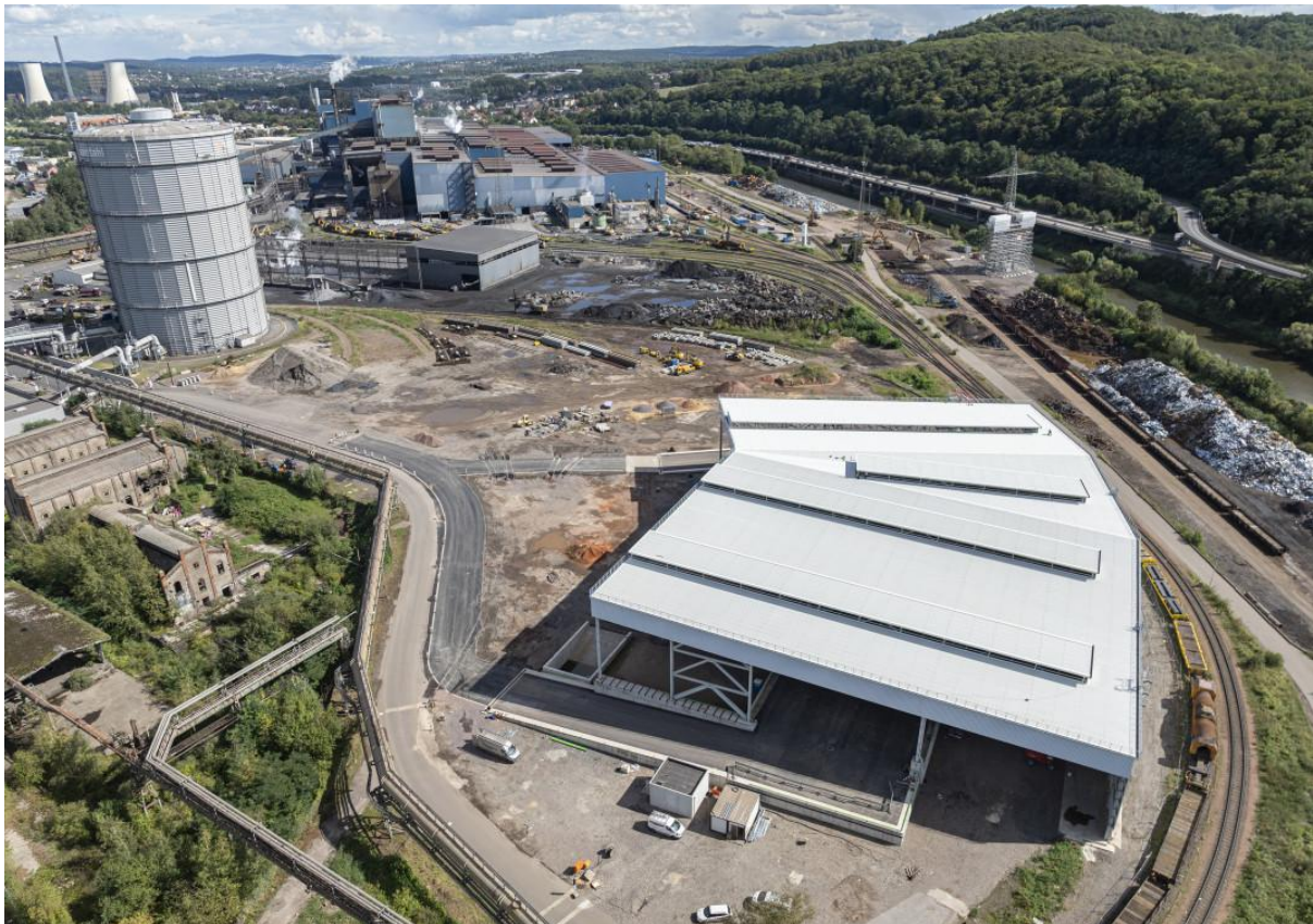
Abbildung 12: Baufeld bei Saarstahl in Völklingen (Stand 2025), Quelle: SHS
